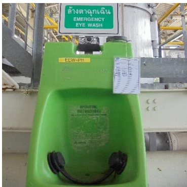
รูปที่ 2-6 อุปกรณ์ล้างตาฉุกเฉินและอุปกรณ์ล้างตัวฉุกเฉิน
